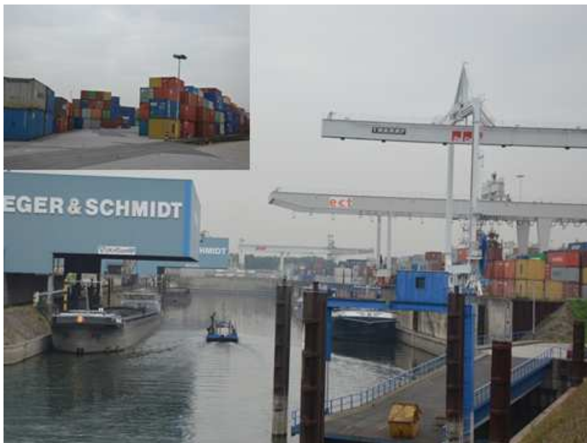
Fot. 3. Największy śródlądowy port rzeczny (kontenerowy) Europy w Duisburgu na Renie (Niemcy), w którym jest zatrudnionych 40 000 pracowników, a którzy jeszcze tak niedawno byli górnikami Zagłębia Ruhry (fot. L. Turowski)
