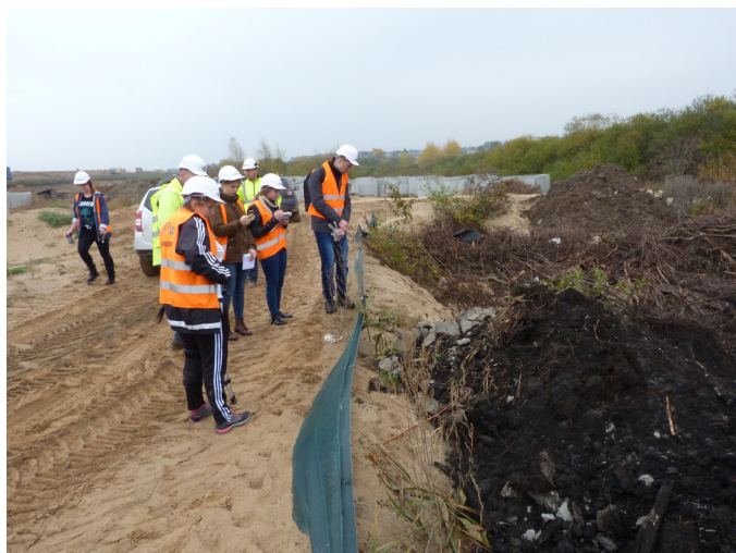
Kurs terenowy dla studentów ochrony środowiska z przedmiotu Zasady minimalizacji i kompensacji przyrodniczej; na zdjęciu płotki dla płazów ograniczające ich śmiertelność (droga S5); zajęcia odbywają się dzięki współpracy z Generalną Dyrekcją Dróg Krajowych i Autostrad.
